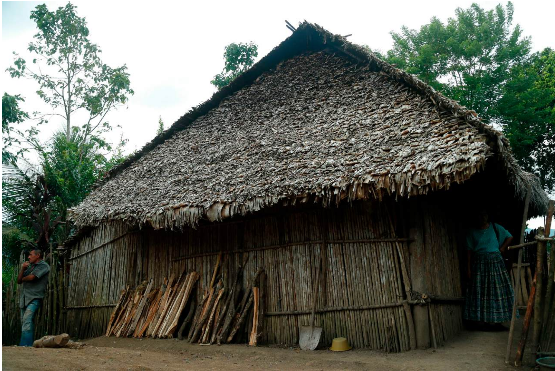
Heliconia roof, Aldea Pinares, Cahabon
